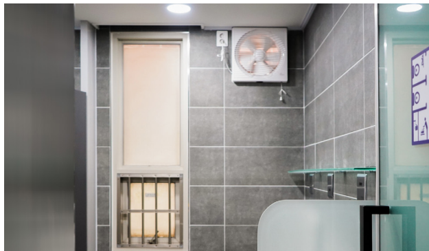
[그림 52] 환풍기 설치
