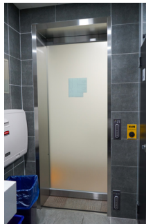
[그림 17] 자동문 시공사례(안쪽)
