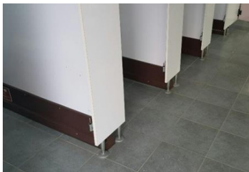
[그림 42] 몰카방지 안심스크린 설치
