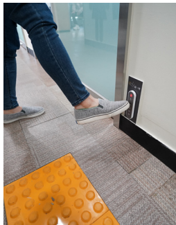
[그림 18] 자동문 풋스위치 설치
