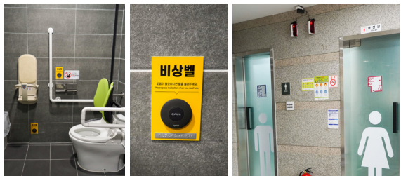
[그림 43] 비상벨 및 경광등 설치
