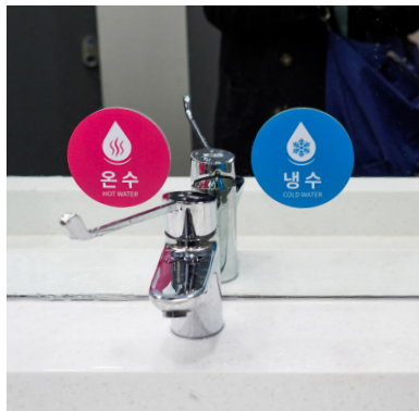
[그림 32] 냉온수 구분 안내표지판 설치
