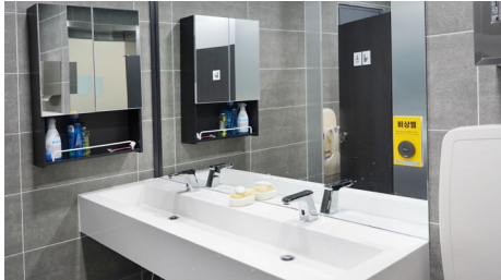
[그림 46] 거울형 선반 설치
