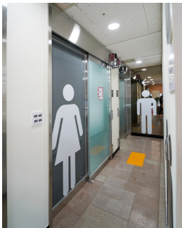
[그림 16] 자동문 시공사례(바깥쪽)
