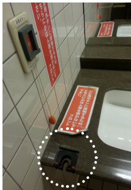
[그림 31] 우산/지팡이 걸이 설치
